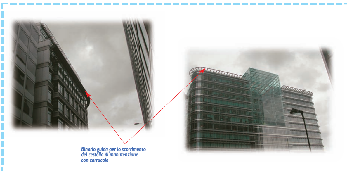
Passerelle di manutenzione marciano sulla facciata vetrata
