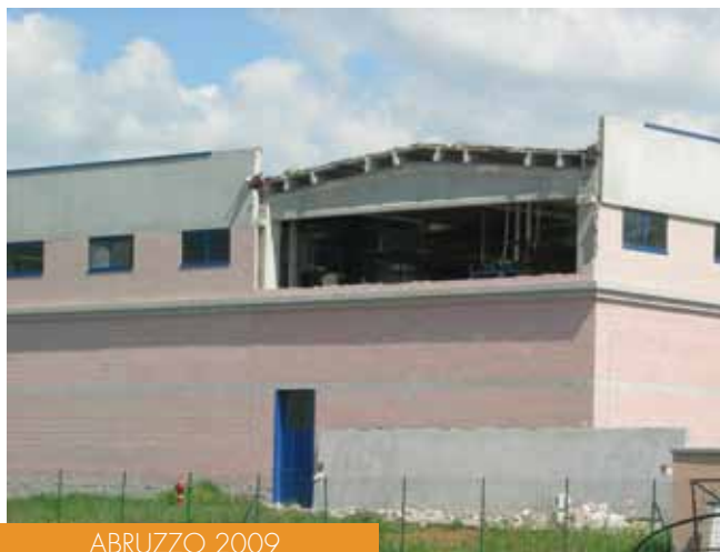
Capannoni industriali: tipico ribaltamento di pannelli pesanti di facciata.
