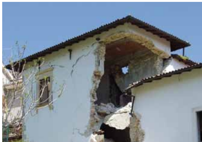
Crolli angolari degli edifici per mancanza di cinturazioni a livelli intermedi e ammassamenti esigui delle murature ortogonali.
