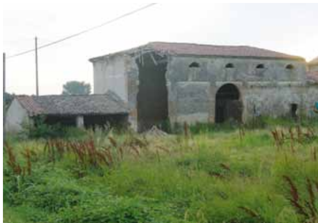
Crolli angolari degli edifici per mancanza di cinturazioni a livelli intermedi e ammassamenti esigui delle murature ortogonali.
