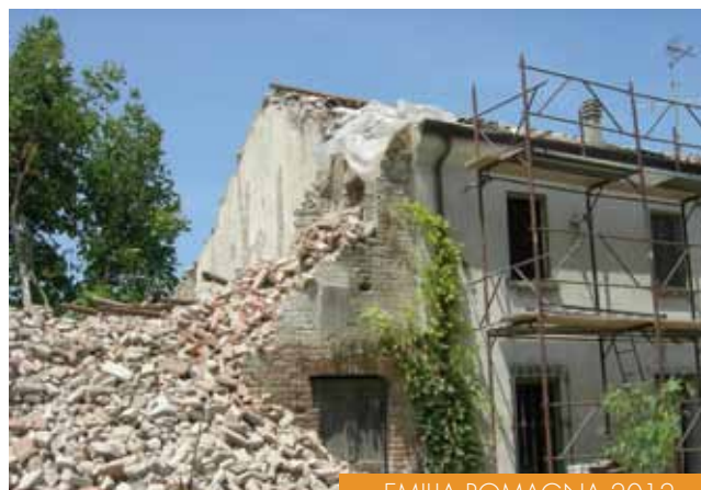
Disgregazione degli edifici per incoerenza delle murature
