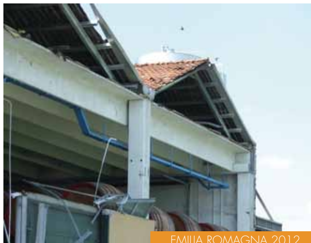
Capannoni industriali: tipico ribaltamento di pannelli pesanti di facciata.
