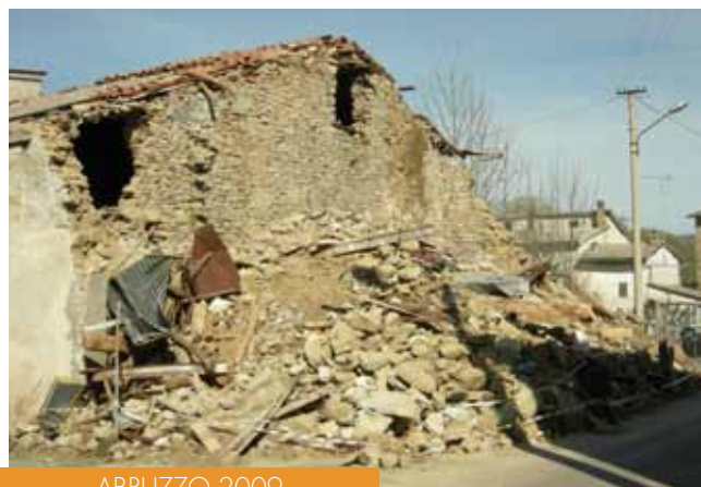
Disgregazione degli edifici per incoerenza delle murature
