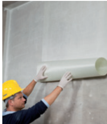
Nella foto un esempio di consolidamento di una muratura interna di un edificio mediante l'applicazione di MapeVWrap EQ System. Si tratta di un sistema composto da due prodotti, un'adesivo monocomponente all'acqua a base di dispersione poliuretanica e di un tessuto bidirezionale in fibra di vetro. La sua applicazione sulle pareti, che può avvenire anche direttamente su intonaco esistente, aumenta il tempo di evacuazione dall'edificio in caso di sisma. Il prodotto è inodore e ha uno spessore di circa 1mm. (Mapei)
