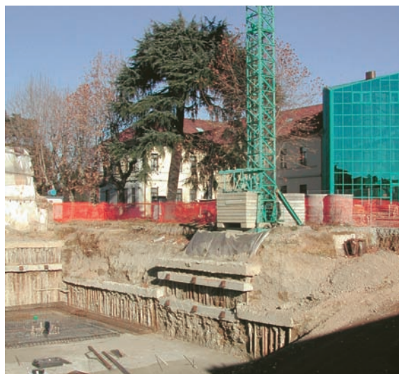
Dove viene posizionata la gru? Attenzione che se la gru è nei pressi dello scavo bisogna prevedere dei rinforzi aggiunti sulle opere attigue di sostegno del terreno. Nella foto, un esempio di rinforzo dello scavo in corrispondenza della gru: Berlinese di micropali con doppia fila di tiranti (anzichè singola come nel resto del cantiere).
