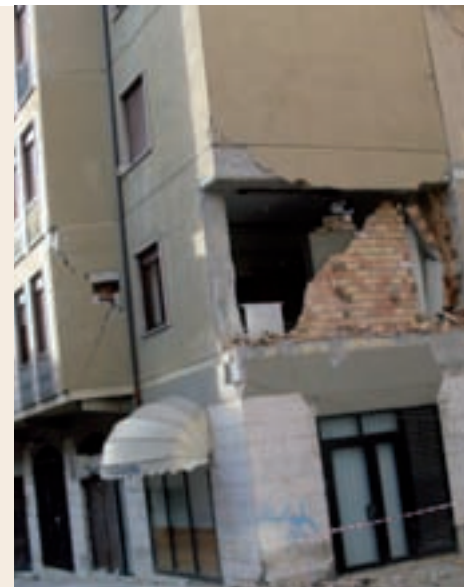
Da sinistra: rottura del vano scala posto su un fianco dell'edificio anziché in zona centrale e, nelle due foto al centro e a destra, scoppio dei tamponamenti murari ai piani bassi di edifici con struttura in c.a.
